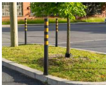
Musoir en béton
